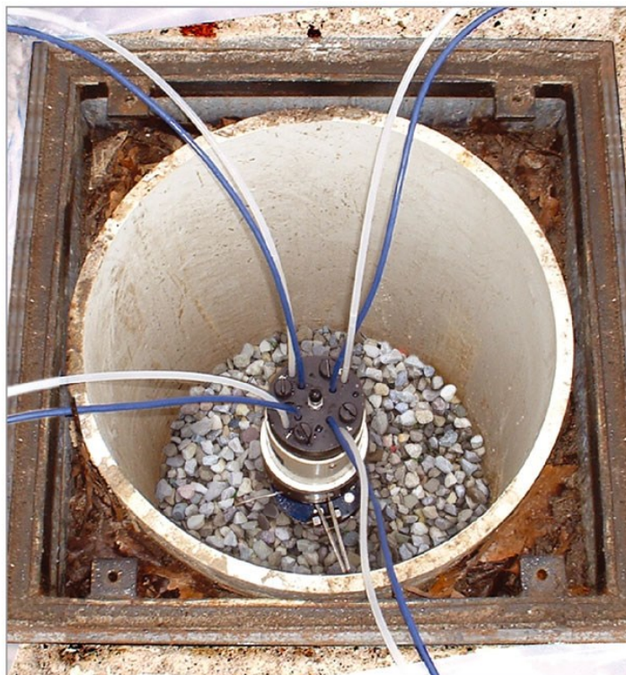
Использование кернов для проектирования зон отбора и установки пакеров (слева). Многоуровневый коллектор с индивидуальными насосами и датчиками давления для четырёх зон (справа).
